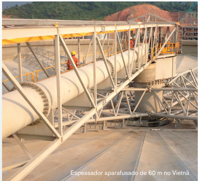
Design avançado do duto de alimentação de 44 m
